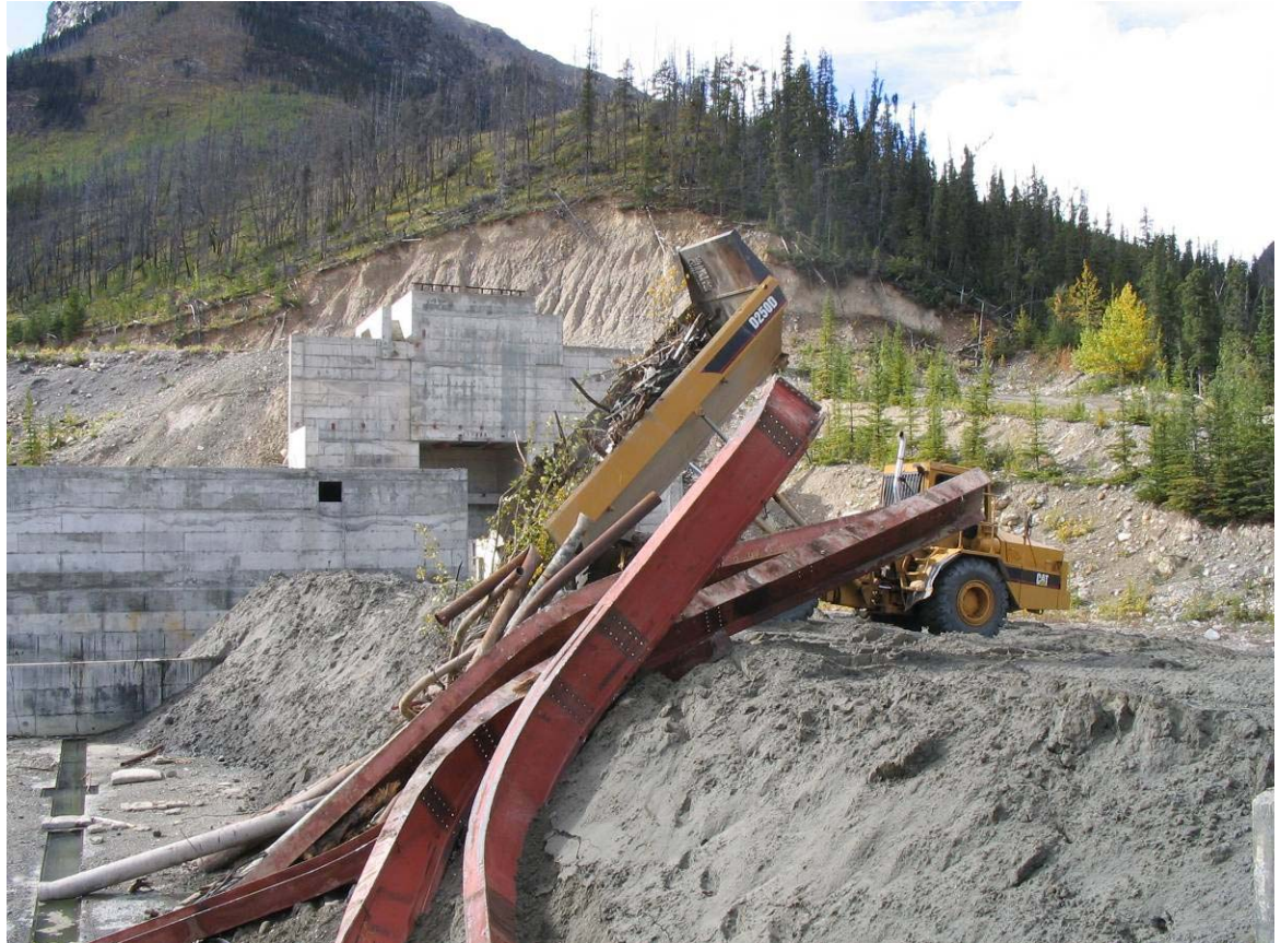
34 - Filling Mill Site Landfill
